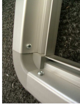
Foto A: particolare di fissaggio delle viti angolari
